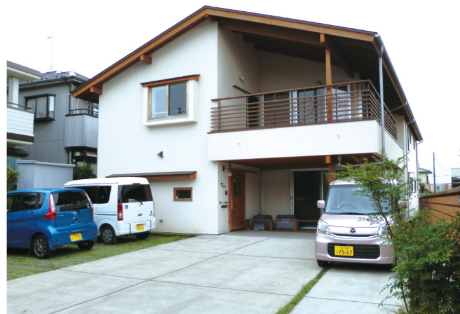
駐車場も広々と確保し、便利な使い勝手が評判のウィズホーム外観
